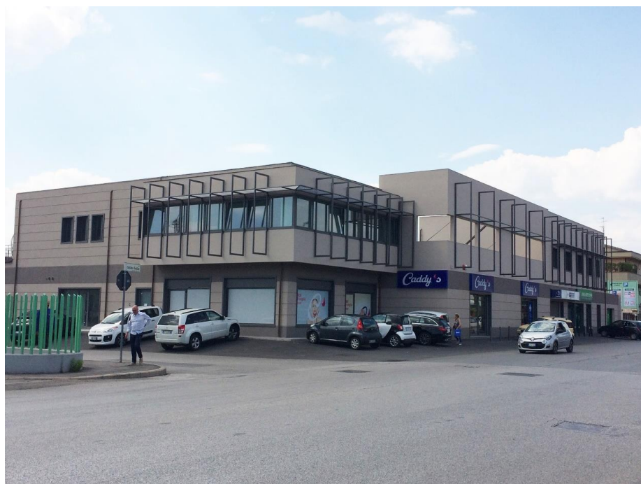
Dopo l'intervento in corso
